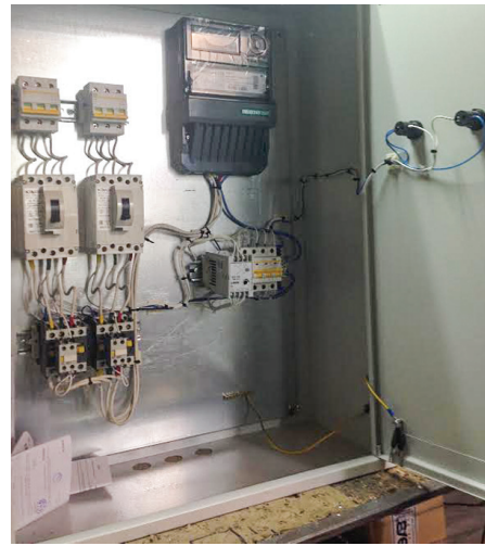
Рис 1.4.1. – Внешний вид шкафов АВР серии ЯА8300.
