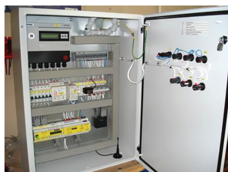
Рис 1.14.1. – Внешний вид шкафа узла учёта газа.
