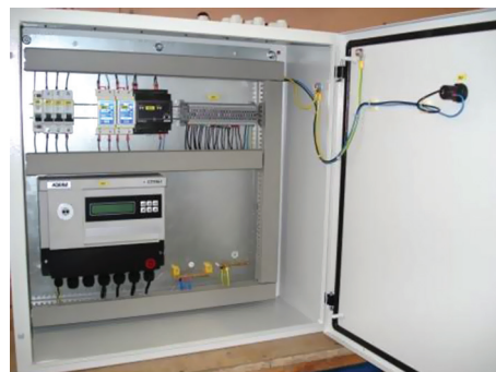
Рис 1.13.1. – Внешний вид шкафа учёта тепловой энергии.
